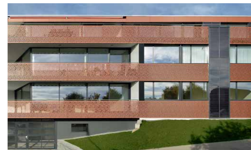
Balustrades de balcons
